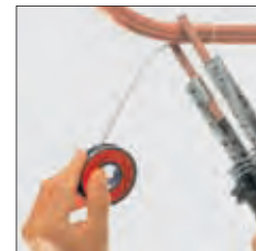
Нагрев места пайки без использования пламени
