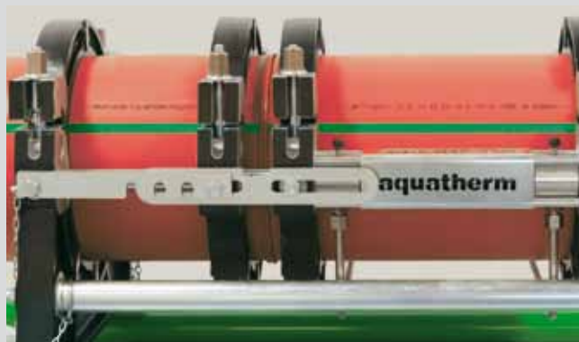
Трубы свести, под давлением дать соединению остыть
